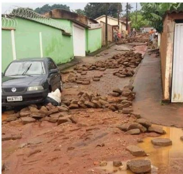
Chuva deixou estragos em Guaranésia (MG) — Foto: Corpo de Bombeiros
