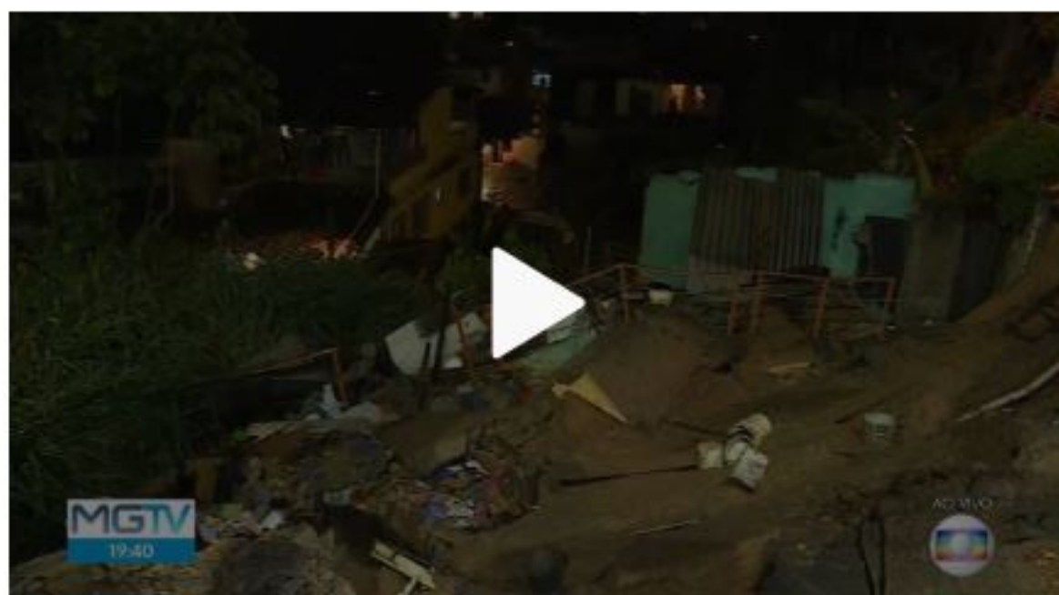
Casa desaba durante temporal em Belo Horizonte
