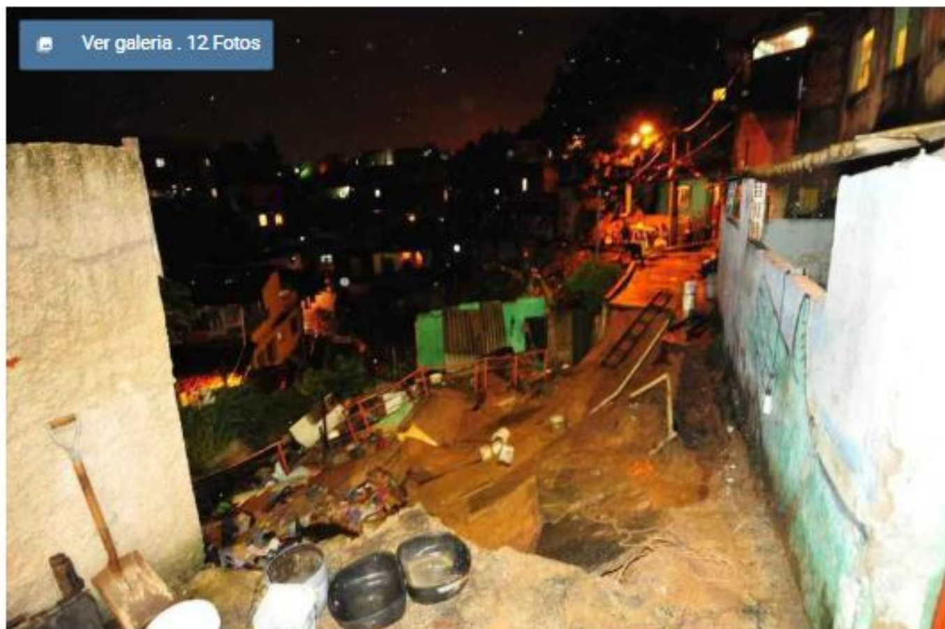
📷 A estrutura da casa cedeu durante o temporal que estingiu a capital mineira no fim da tarde. Duas mulheres foram soterradas e foram retiradas com vida
