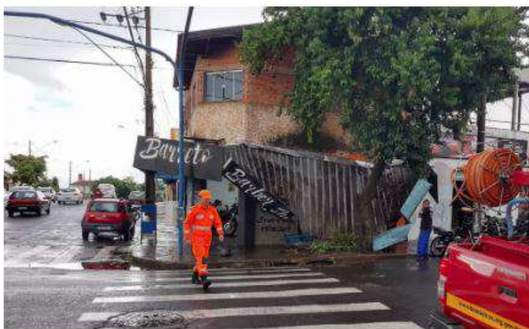
Telhado de estabelecimento comercial desaba durante chuva em Uberaba. — Foto: Corpo de Bombeiros/Divulgação
