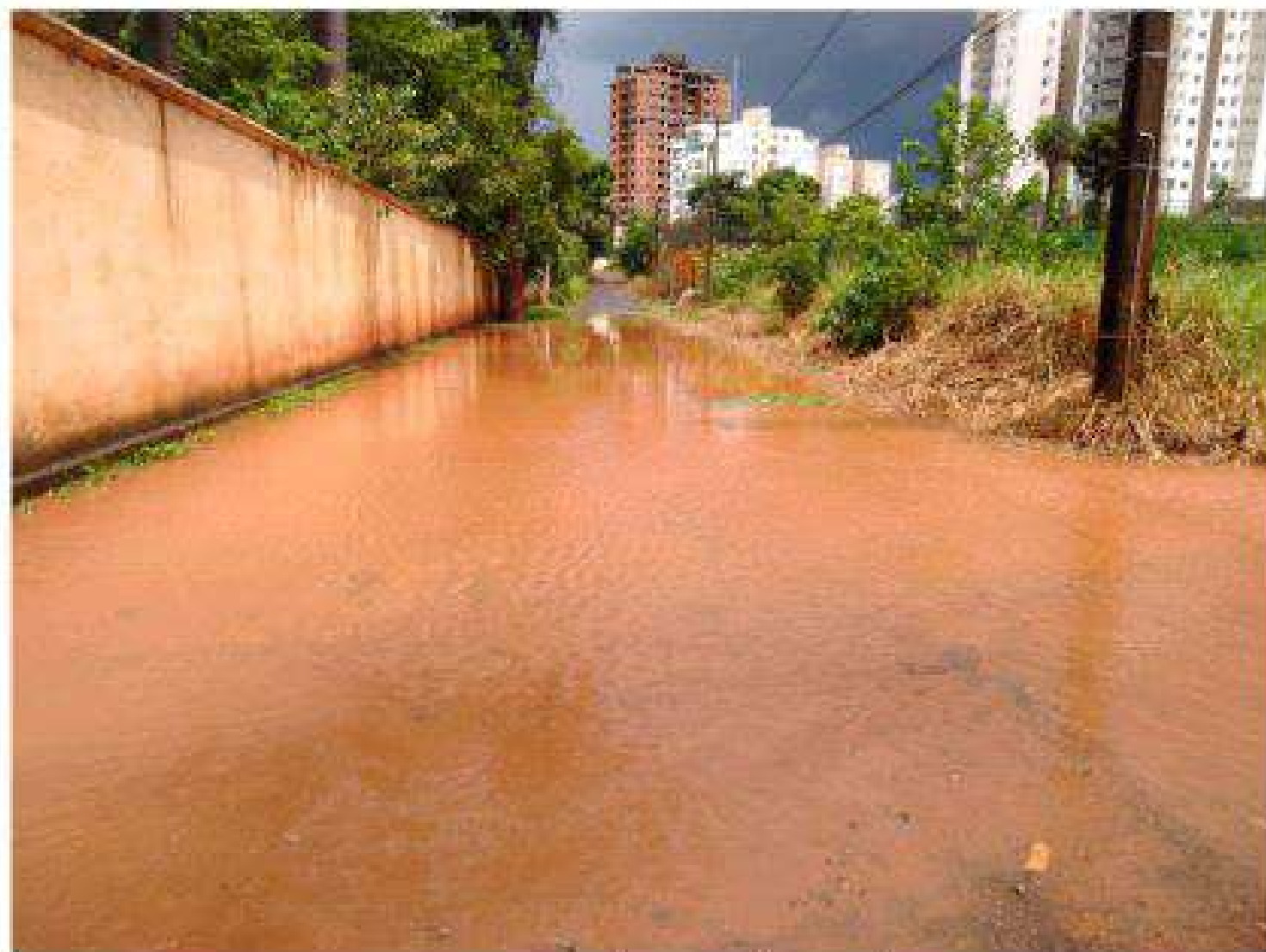
Pontos de alagamentos foram registrados na zona sul de Uberlândia | Foto: Diário de Uberlândia
