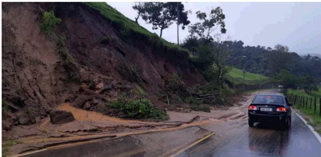
Trechos de rodovia em Bandeira do sul (MG) tiveram deslizamentos — Foto: João Daniel Alves/EPTV
