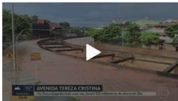
Moradores acumulam prejuízos após alagamento da Avenida Tereza Cristina, em BH
