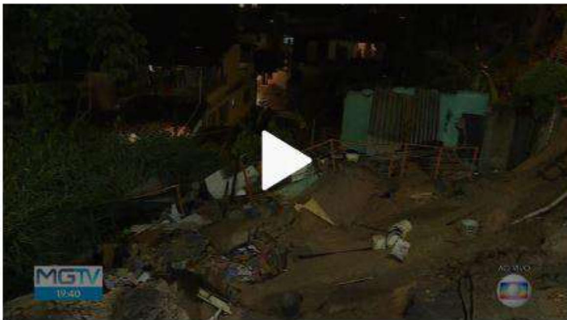
Casa desaba durante temporal em Belo Horizonte.
