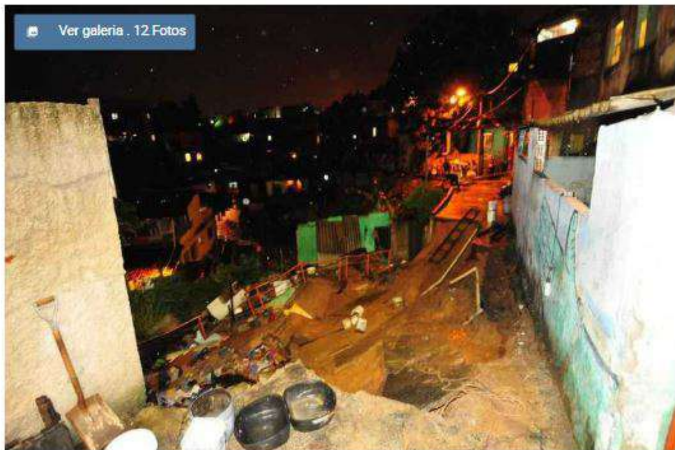
A estrutura da casa cedeu durante o temporal que estinguiu a capital mineira no fim da tarde. Duas mulheres foram soterradas e foram retiradas com vida
