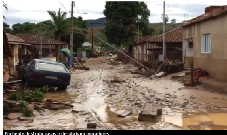
Enchente destruiu casas e desabrigou moradores
