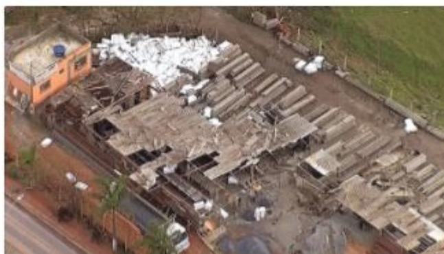
Fábrica destruída durante a chuva em Ribeirão das Neves (foto: Reprodução/TV Globo)
