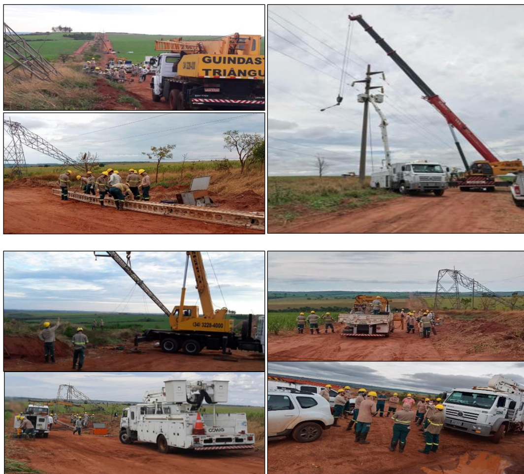
Figura 5: Registros da atuação das equipes na recomposição das estruturas
