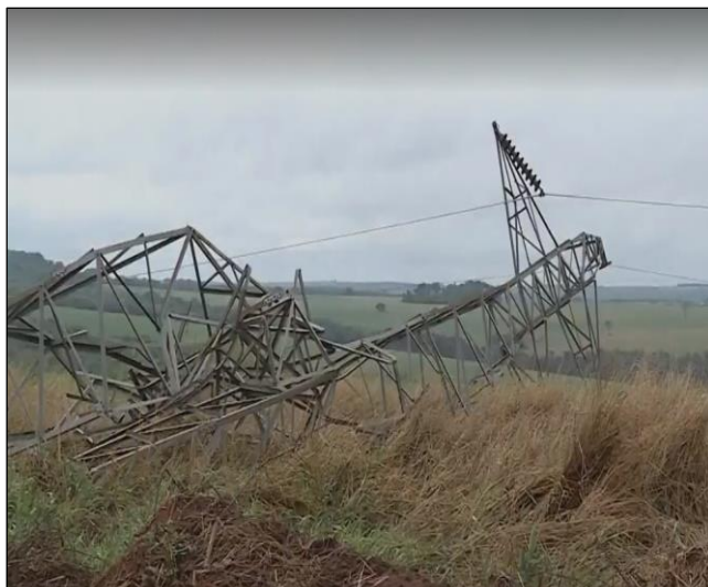
Figura 3: Registro de estrutura da LD Avatinguara – Ituiutaba 138kV ao solo
