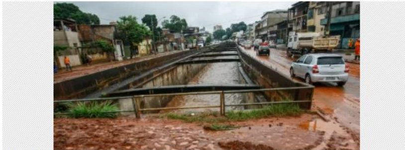
Chuva causa estragos no bairro Salgado Filho, na zona oeste de Belo Horizonte Imagem: Pedro Gontijo/Hoje em Dia/Estação Conteúdo
