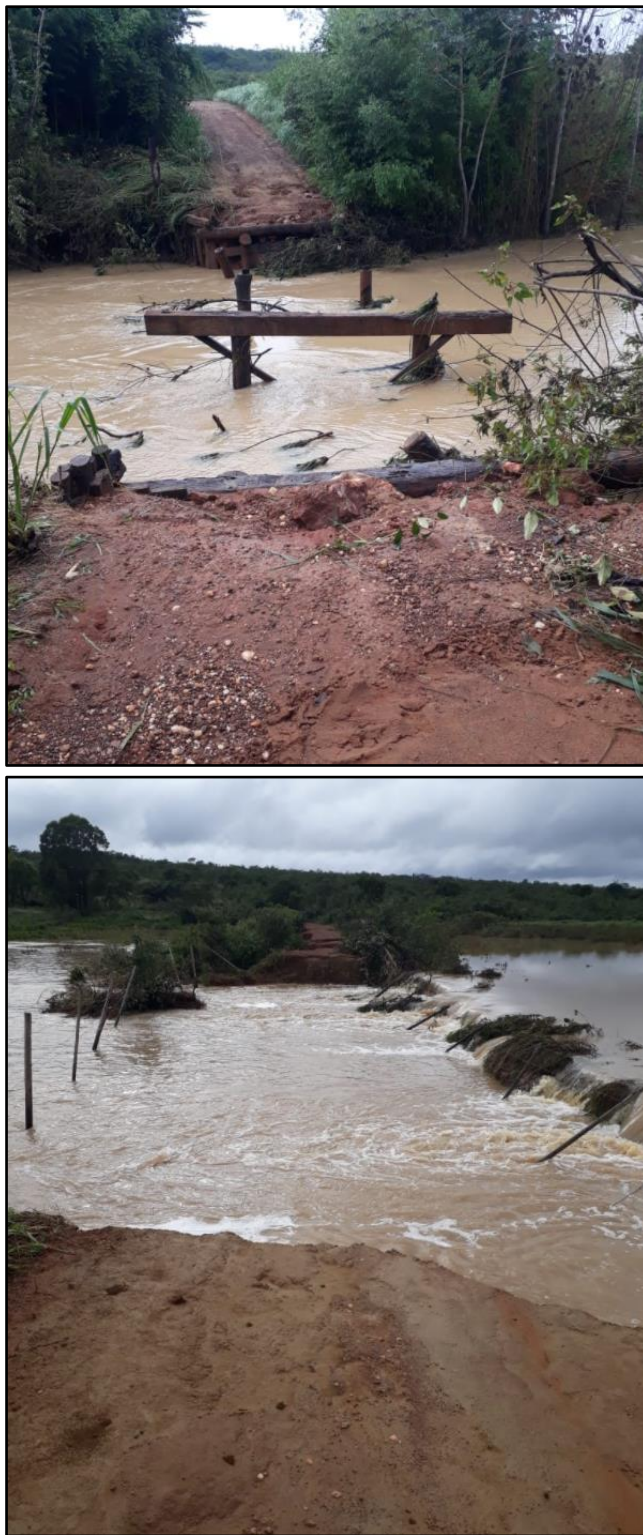
Figura 8: Ponte levada pela correnteza e estrada de acesso destruída em Rio Pardo de Minas
