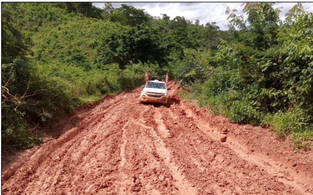
Figura 9: Estrada intransitável próximo à Santa Teresa do Bonito, no município de Peçanha
