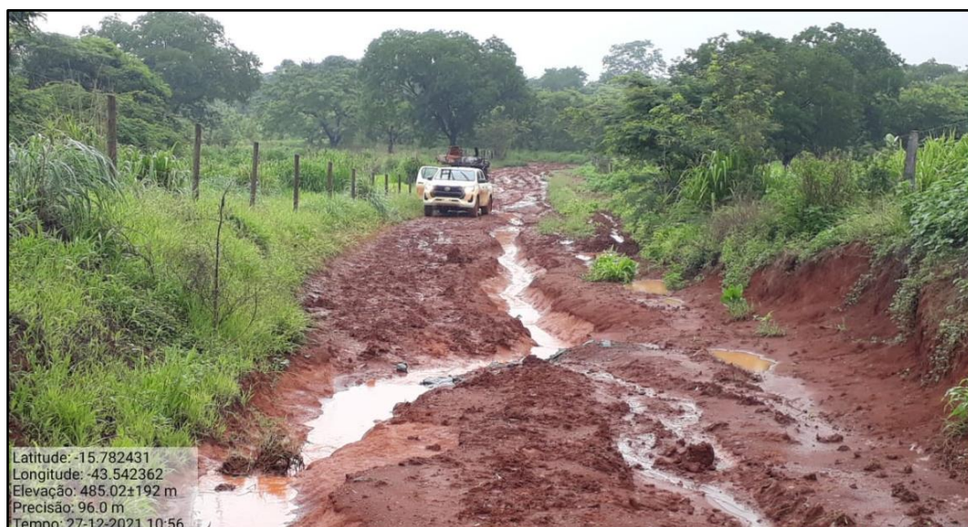
Figura 10: Estrada intransitável próximo à Janaúba
